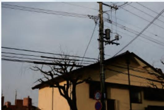
日本因地震多，因此輸電線路很多並無地下化，因為地下化後遇地震受損後復舊不易，日本人很珍惜樹木，對於長在輸電線上之樹枝，如果在臺灣必然「理光頭」侍候，但他們卻用絕緣套管來防止短路情事取代以「理光頭」方式處理。
